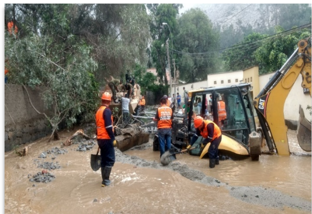
Ilustración 8. Despliegue de maquinaria de ingeniería
